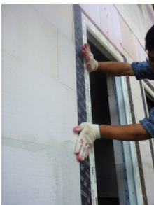
2.4 다른 한쪽의 테이프 접착면을 제거 후 눌러서 접착한다 순서는 가능한 아래면<옆면<윗면 순으로 시공
