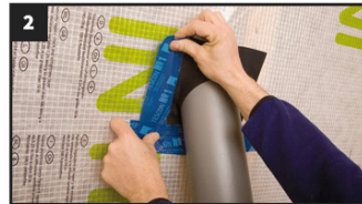
2 Roflex 테두리 부분에 VANA테이프를 사용하여 접착해줍니다.
