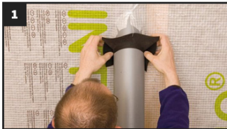
1 시공 전 적용부위를 깨끗하게 한 후 배관 사이즈에 맞는 Roflex를 끼워줍니다.
