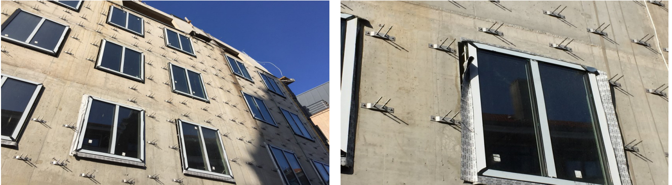
독일 하이델베르크 패시브하우스 단지 현장
