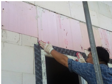
2.4 다른 한쪽의 테이프 접착면을 제거 후 눌러서 접착한다 순서는 가능한 아래면<옆면<윗면 순으로 시공
