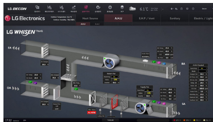
시스템에어컨 외 설비 자동제어 감시 및 제어
