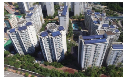
아파트 옥상 설치 PV
