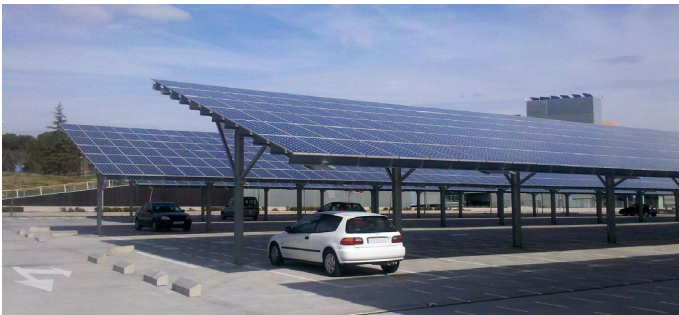
주차장 설치 PV
