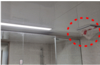
화장실 배기팬 밀봉
