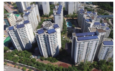
아파트 옥상 설치 PV
