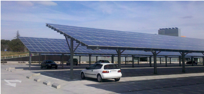
주차장 설치 PV
