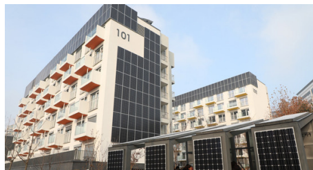
아파트 수직 외벽 설치 PV
