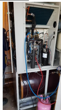
HP 및 센서 설치
