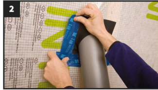
2 Roflex 테두리 부분에 VANA테이프를 사용하여 접착해줍니다.
