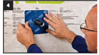
4 Roflex20 제품은 Kaflex mono와 같이 자착테이프로 이루어져 있습니다. ※ Kaflex mono와 동일한 방법으로 시공하면 됩니다.
