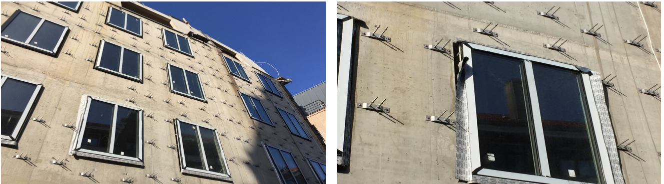
독일 하이델베르크 패시브하우스 단지 현장
