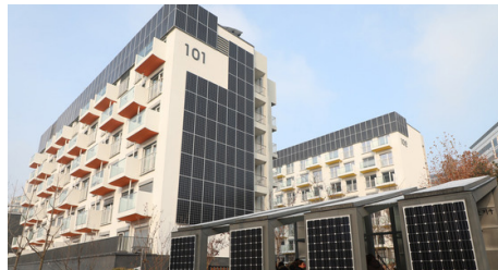
아파트 수직 외벽 설치 PV
