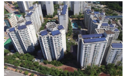
아파트 옥상 설치 PV
